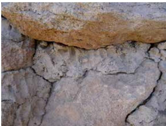
Figura 9. Detalle de marcas de dedos en el barro de una junta exterior.
