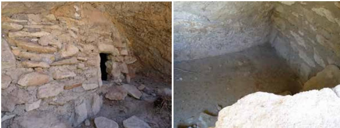
Figuras 7 y 8. El contraste en el tratamiento de las juntas de barro en una misma estructura (CAN-XI-03): juntas tomadas en el exterior y al ras en el interior.
