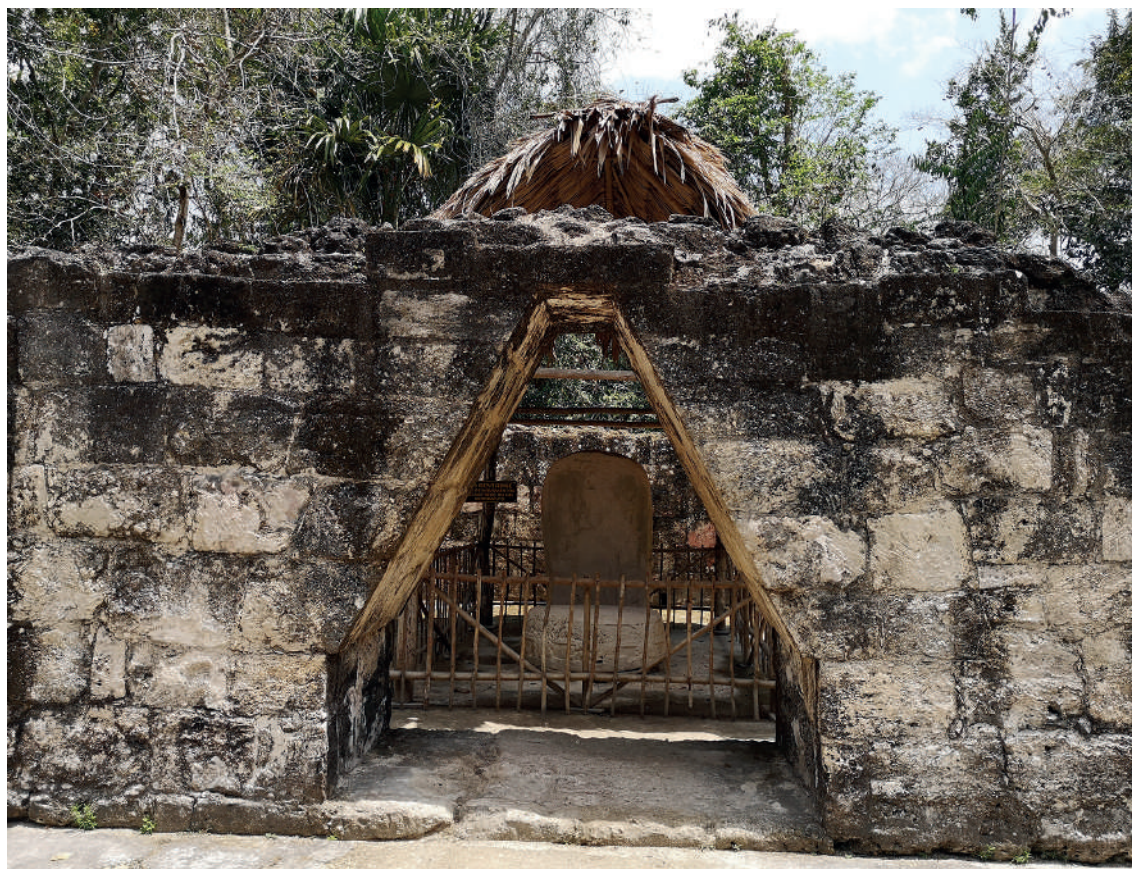
Figura 7. Estructura 4E-39, Complejo Q Pirámides Gemelas, Tikal (fotografía de la autora). Figure 7. Structure 4E-39, Twin Pyramid Complex Q, Tikal (photo by the author).
